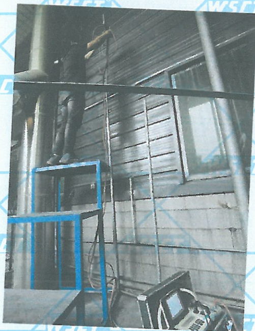
配碳工序废气排放口
